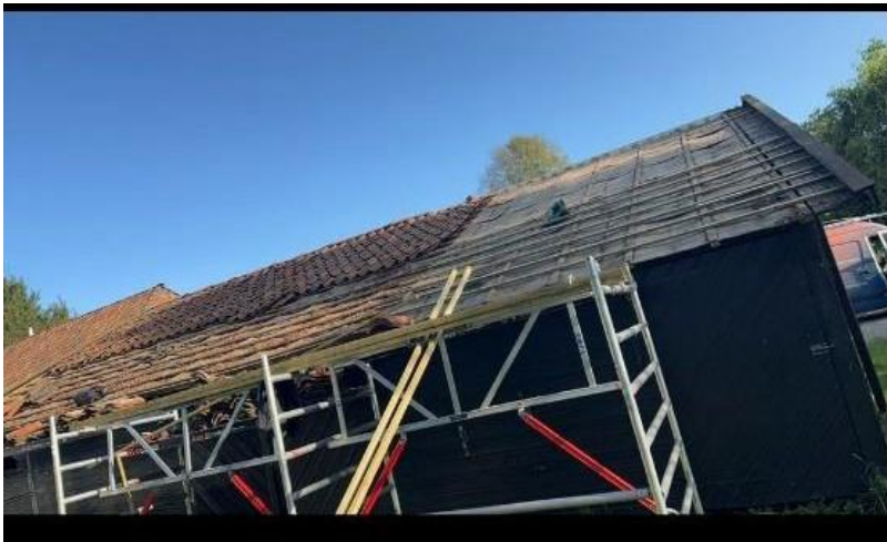
Dachziegel entfernen.
