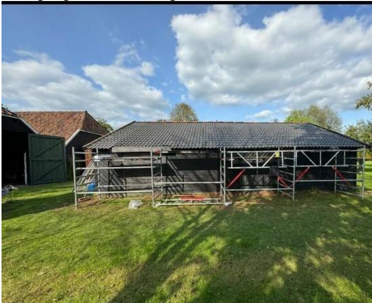
Verlegung der neuen Dachziegel.
