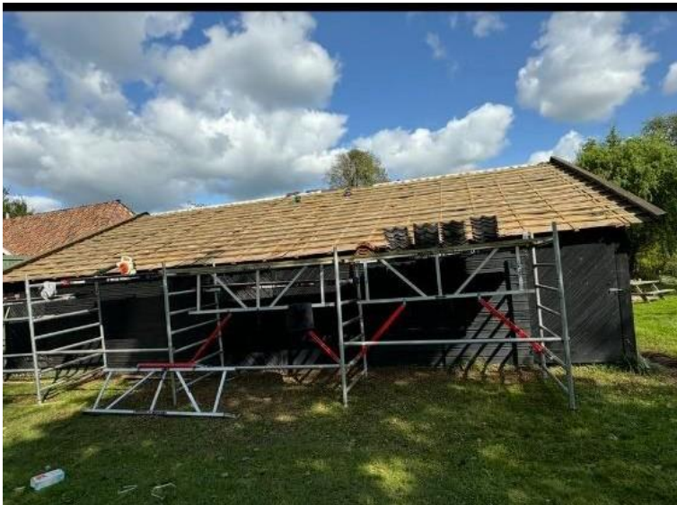
Verlegung neuer Dachziegel.
