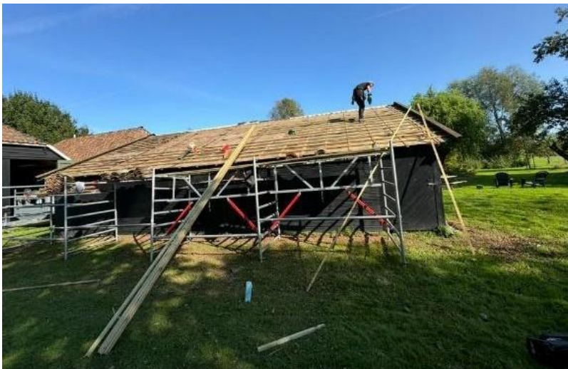
Dachziegel entfernen. Ganzes Dach mit neuem Holzwerk versehen.
