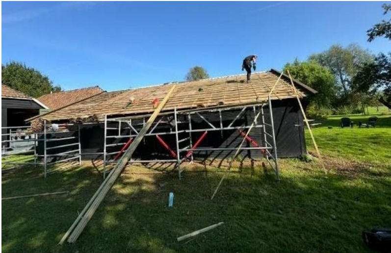
Dakpannen verwijderen. Gehele dak voorzien van nieuw houtwerk.
