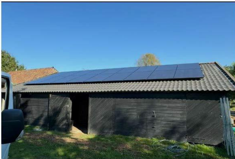
Installatie van 18 PV-panelen.
