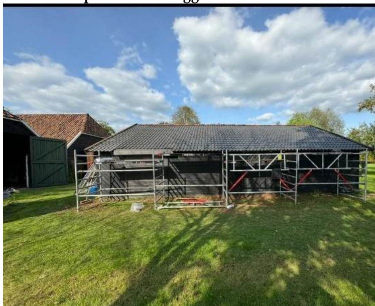
Plaatsen van nieuwe dakpannen.
