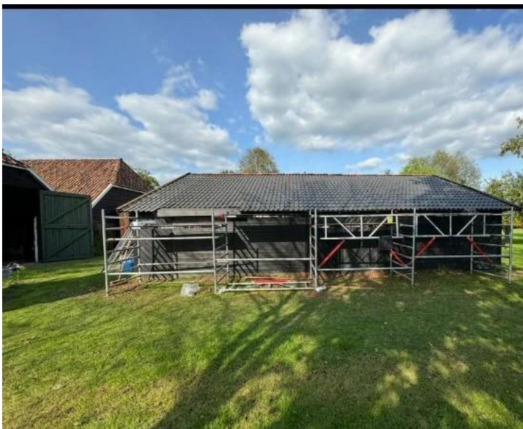
Uusien kattotiilien asennus.
