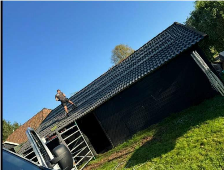
Koko katto varustettu kiskoilla aurinkopaneelien asennusta varten.
