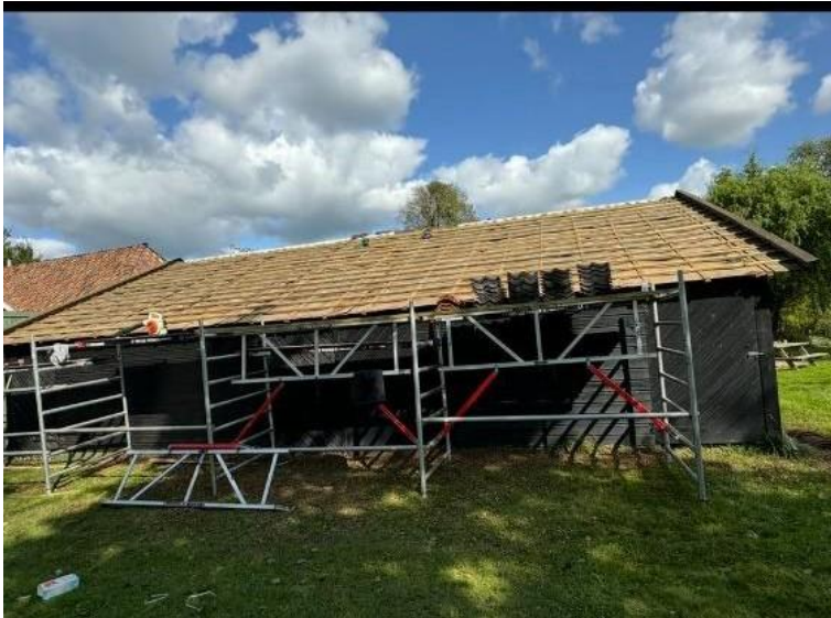
Uusien kattotiilien asennusvalmius.
