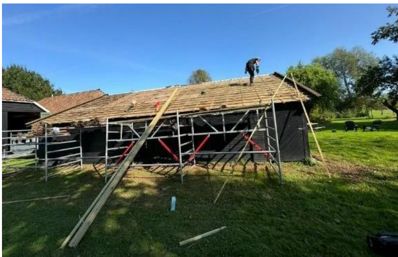
Poistetaan kattotiilet. Koko katto varustetaan uudella puurakenteella.
