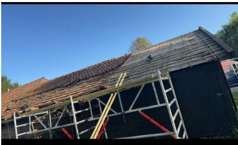
Kattotiilien poisto.
